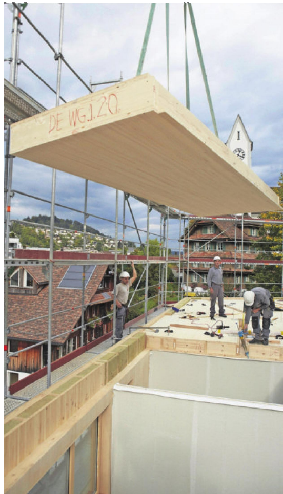
Arbeiten am Vorzeigeprojekt der Alpnacher Firma Küng in Kriens – dem Plus-Energiehaus. PD
