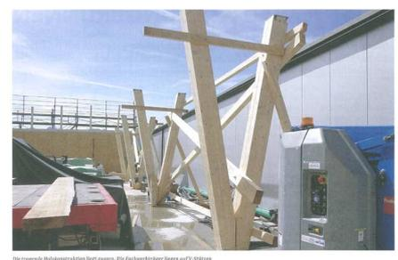
Die tragende Holzkonstruktion liegt aussen. Die Fachwerktträger liegen auf V-Säulen und überspannen eine Gebäuhöhe von 23 Metern.
