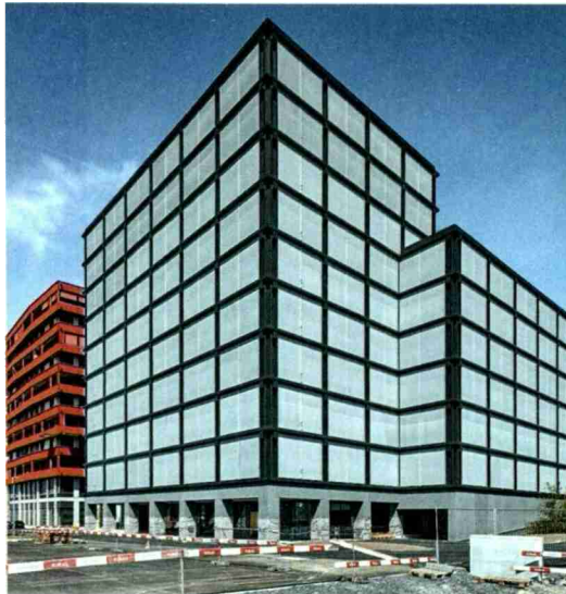
Silber für das erste Schweizer Holzhochhaus. Es steht auf dem Suurstoffi-Areal in Risch Rotkreuz.
