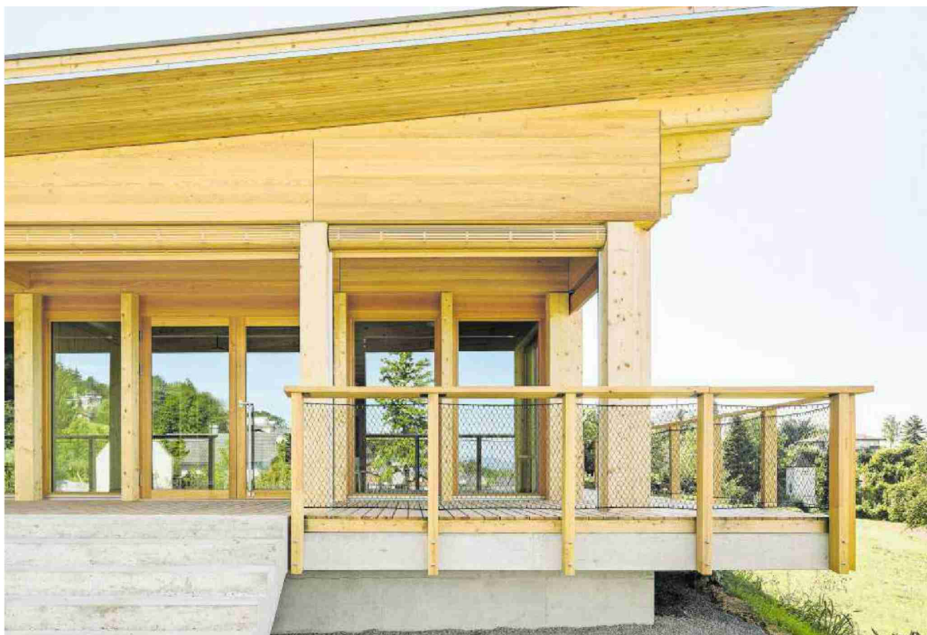
Angenehmes Raumklima dank Holz: Seit einem Jahr werden Kindergärtler im preisgekrönten Gebäude unterrichtet.
