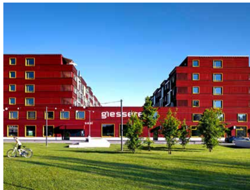
Holzbau im urbanen Raum: «Giesserei» in Winterthur. BILD HANNES HENZ, ZÜRICH
