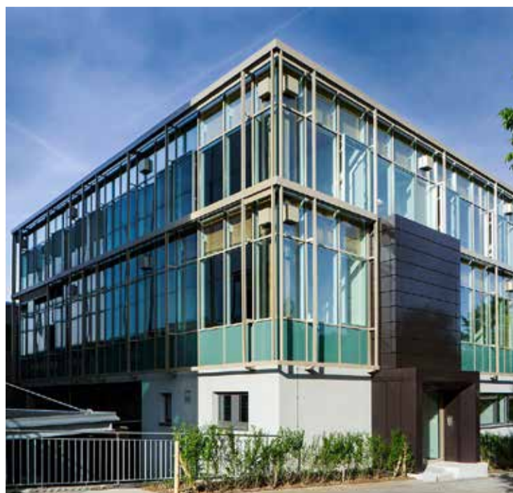
Innovative Laubholzkonstruktion: «House of Natural Resources». BILD MARCO CAROCARI, ETH ZÜRICH
