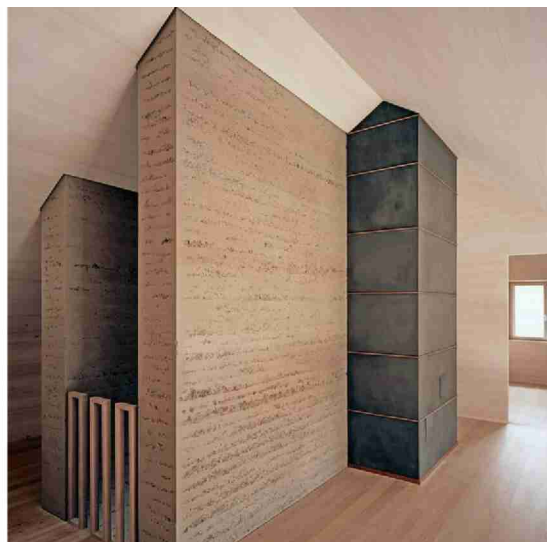
Stilvolles Detail: Die Schnitzereien stammen aus Künstlerhand (r.), Gestampfter Lehm: Für das Treppenhaus wurde der Aushub verwendet (r. aussen)
