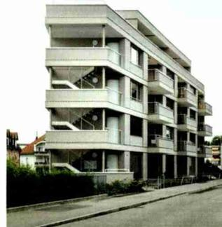
Dank seiner besonderen Eigenschaften ermöglichte Holz eine Gebäudeaufstockung, wie sie in einer anderen Bauweise kaum möglich gewesen wäre. Bild: Till Forrer
