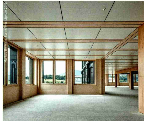
Die modulare Tragstruktur ist im Innern gut erkennbar und gereicht dem Bürogebäude zur Zierde.
