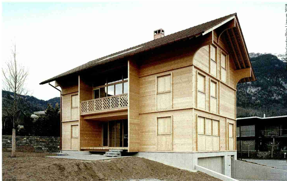
Nichts geklebt oder genagelt – alles gedübelt! Auch das Mondhaus in Alpnach wurde mit dem Sonderpreis Schweizer Holz bedacht.
