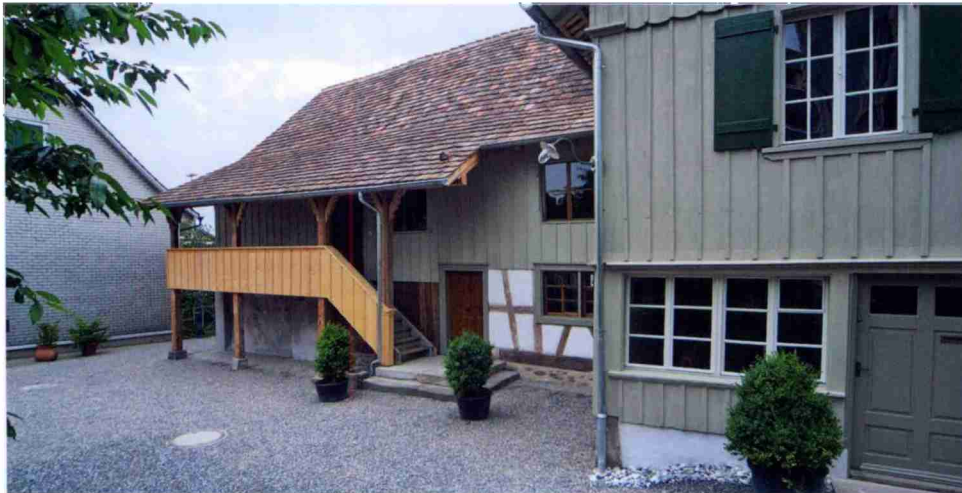
Bestehendes und neues Holz ergänzt sich im historischen Fischerhaus in Romanshorn. Dieses Projekt wurde mit dem Prix Lignum ausgezeichnet. Foto: Lignum Schweiz
