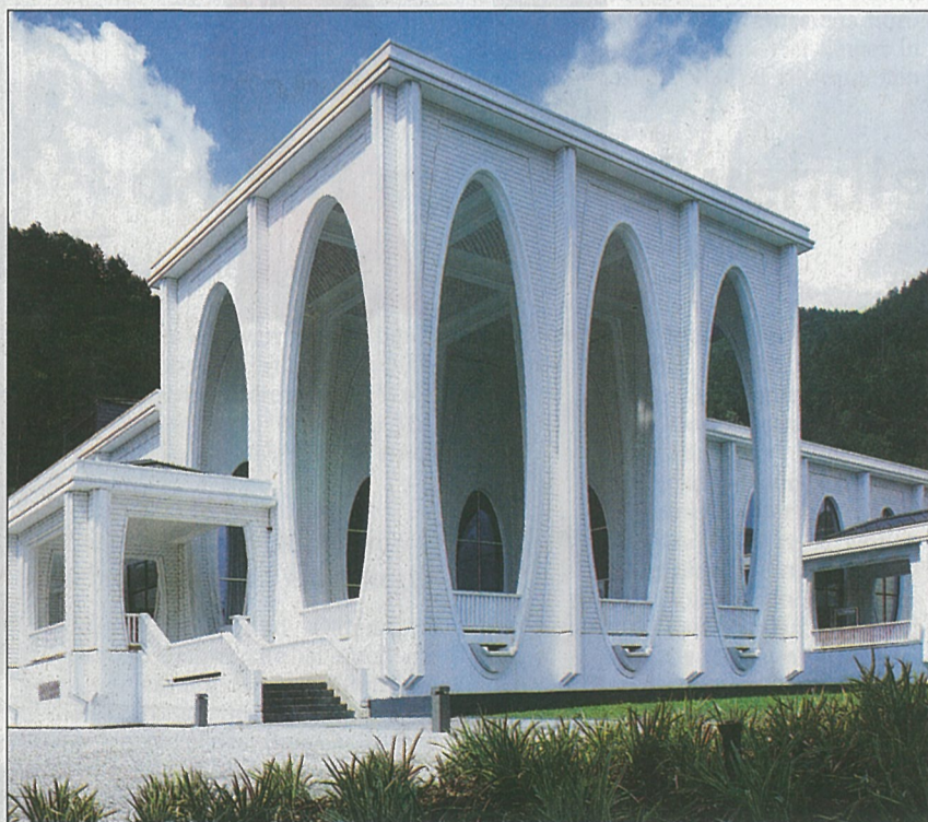
Der dritte Preis ging an die Tamina-Therme in Bad Ragaz. Der Neubau inmitten einer Parklandschaft zeigt sich als formal opulenter, reiner Holzbau, der im Innern mit einer lichtdurchfluteten, strahlend weißen Raumstruktur überzeugt.
