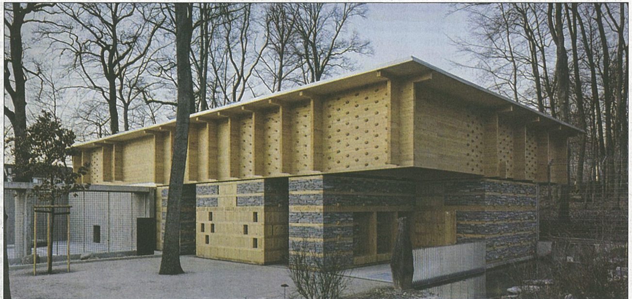
Den ersten Preis gewann das Bären-Waldhaus in Bern. Der Bau thematisiert den Wald als Lebensraum der Bären. Die Wände aus Trockenstein-Holzverbund-Mauern tragen das Blockbaudach. Die Blockbaukonstruktion ist in statisch stark beanspruchten Bereichen mit Eichen-Schubdübeln als verdübelter Balken ausgebildet. Bauherrschafft: Tierpark Dählhölzli und Stadtbauten Bern. Foto: Ralph Hut, Zürich
