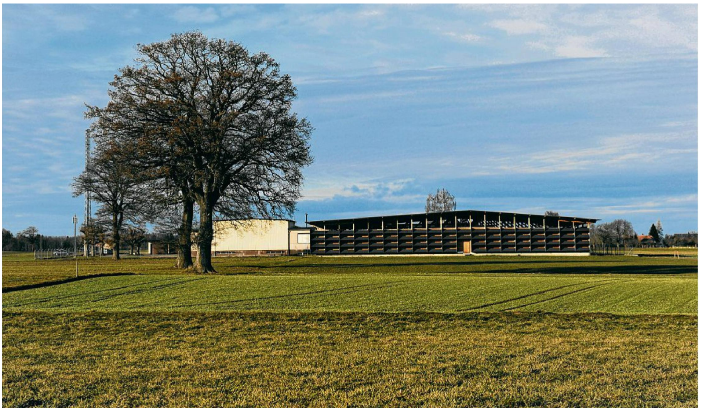
Der Holzbau hat das Prädikat Gold erhalten. Links davon ist das Gebäude des ehemaligen Kurzwellensenders.
