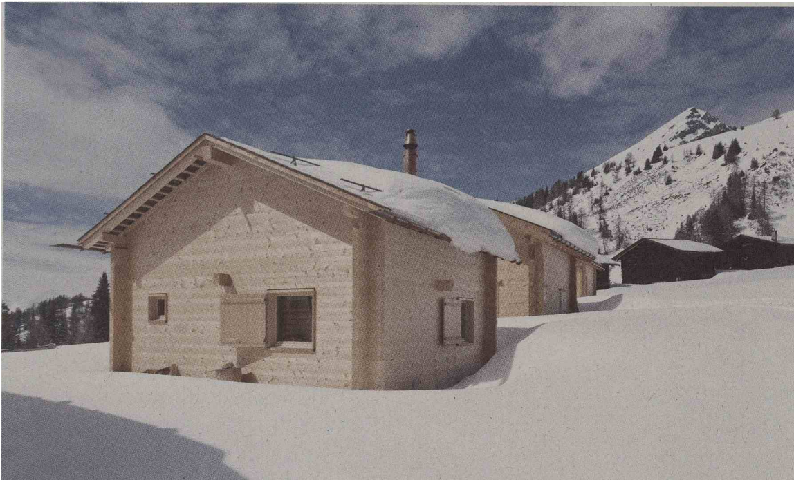
Die mit dem 1. Preis ausgezeichnete Hütte, ein einfach konstruierter Strickbau aus Tanne mit Satteldach.
